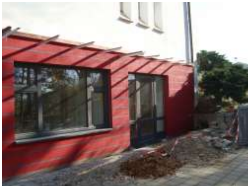
Abbildung 10 Außenfassade der Jugendräume hebt sich nun von der anderen Bebauung ab
